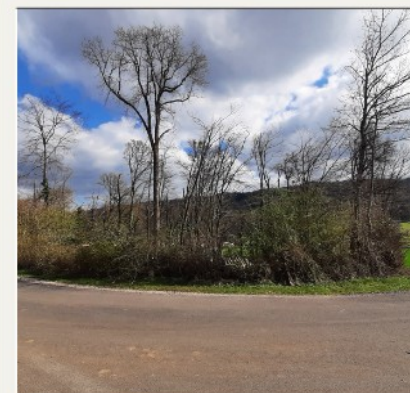
Réfection du virage - Rue du Stade
