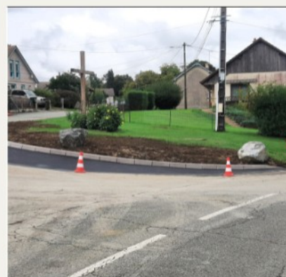
Réfection du virage
