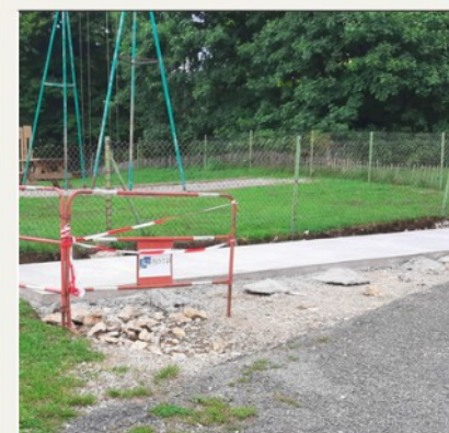
Création plateforme pour containers
