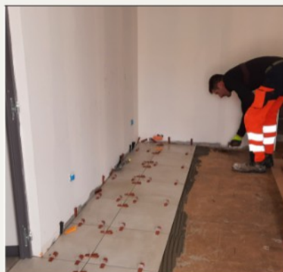
Réfection de l'entrée de la Mairie
